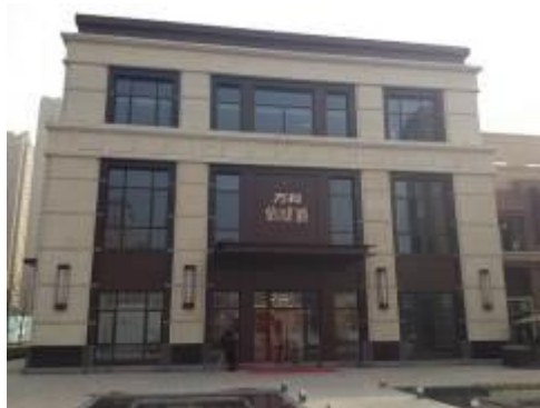
万科信成道外墙装饰工程
