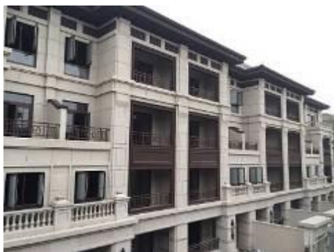
阳光城花满墅外墙装饰工程
