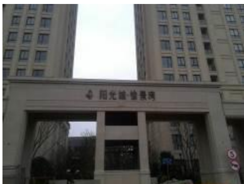
阳光城川沙外墙石材装饰工程
